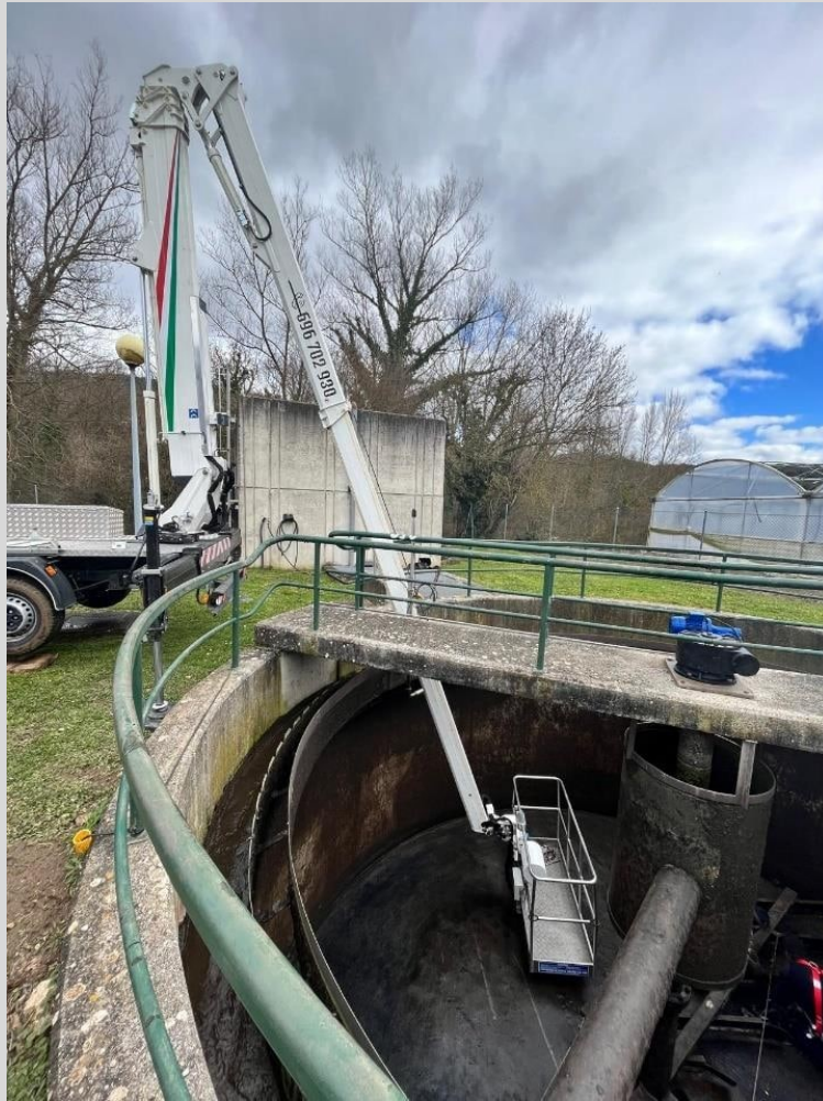
Het halfronde werkdiagram in actie, ver onder het maaiveld
