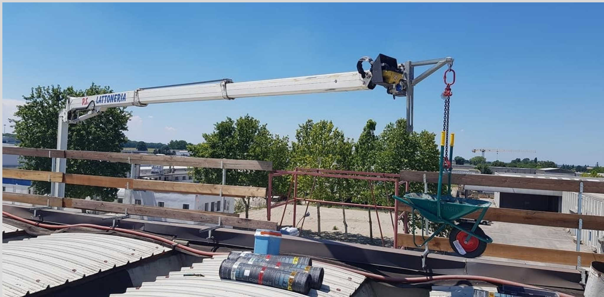
Ploščadi linije CELA Advanced DT so certificirane kot dvizne delovne ploščadi in kot žerjavi
